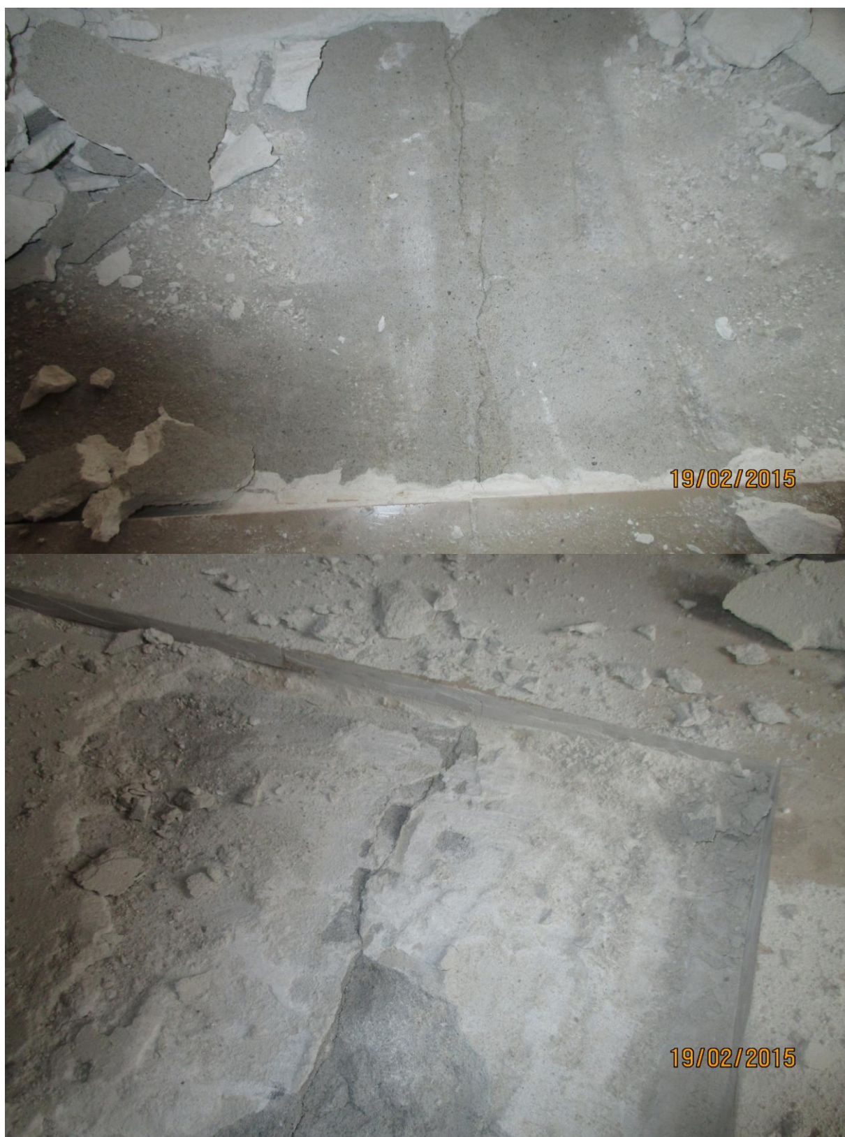
Fot. 7 i 8 Odkrywka – spękania podłoża.
