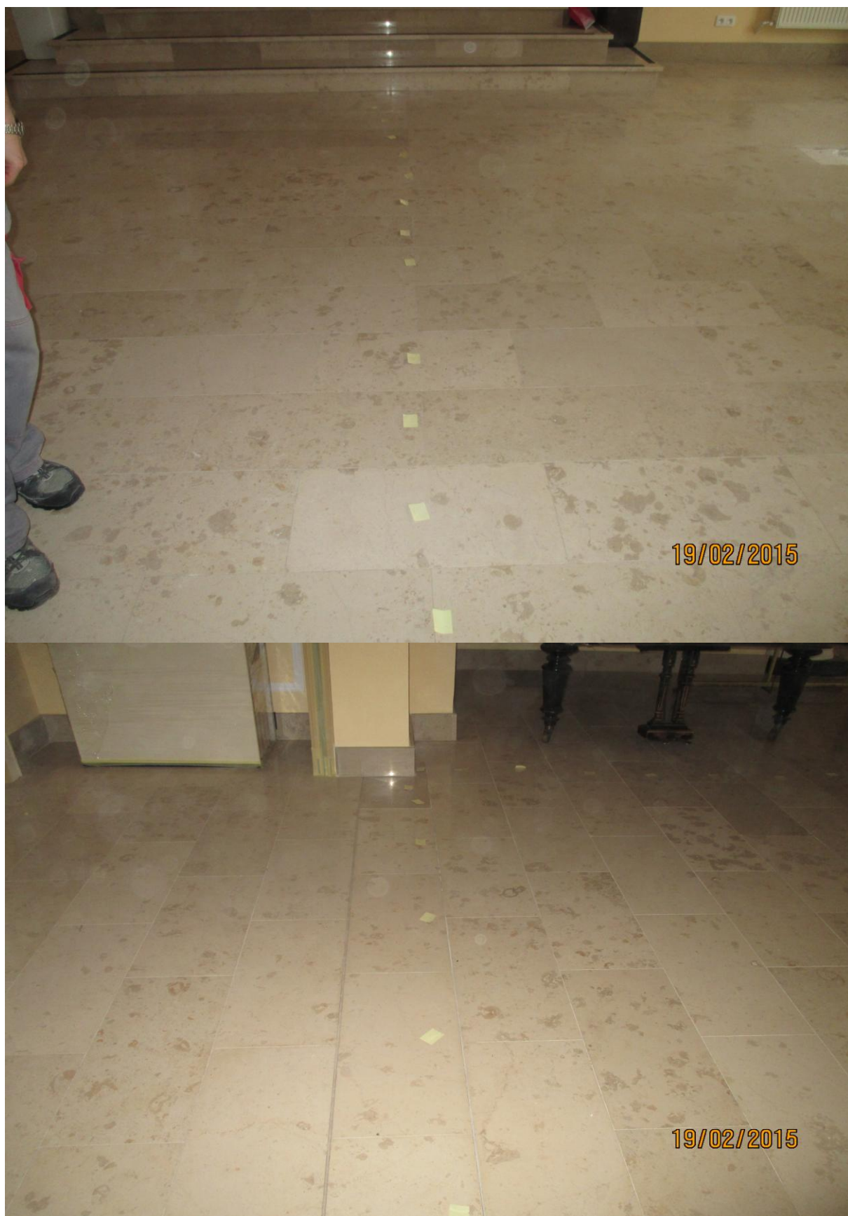
Fot. 5 i 6 zaznaczone pęknięcia płyt
