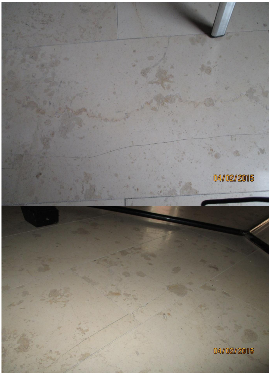
Fot. 1 i 2 Wzdłużne pęknięcia płyt równoległe do fug
